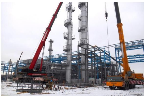
На территории действующего завода смонтировано технологическое оборудование, изготовленное в США. Завершены работы по монтажу оборудования и устройству технологических эстакад. В настоящий момент ведется обвязка установленного оборудования, монтируются трубопроводы и сети электроснабжения. На строительной площадке построен
