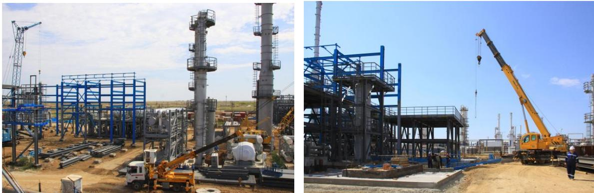
За период с сентября по ноябрь 2015 года подрядчиком выполнен монтаж более 1000 тонн металлоконструкций эстакад и площадок под оборудование, завершен монтаж технологического оборудования, начата его обвязка.
