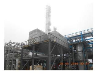
На площадке блока гидроочистки нафты, предназначенного для снижения содержания серы в прямогонном бензине до уровня Евро-5, закончены работы по технологической обвязке, продолжаются работы по гидравлическому испытанию технологических трубопроводов.
