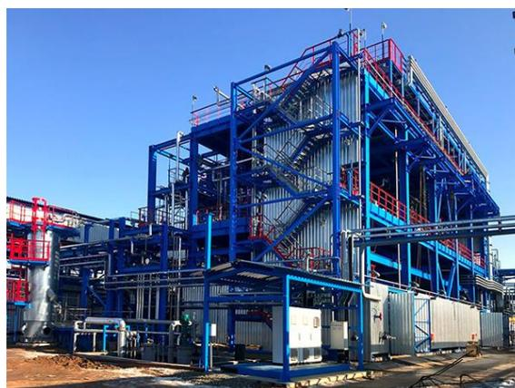
На реализации проекта задействован ряд подрядных организаций. Усилиями специалистов подрядных организаций и персонала АО «Конденсат» строительство установки по выпуску дизельного топлива идет полным ходом. Завершено устройство инженерных и электротехнических сетей, смонтирована большая часть технологического оборудования и трубопроводов.
