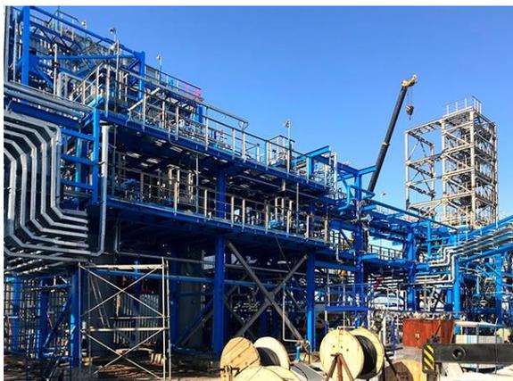
Продолжаются строительно-монтажные работы по печному блоку. Смонтированы металлоконструкции технологических эстакад, подведены технологические трубопроводы. Блок на 95% готов к монтажу печи нагрева газосырьевой смеси и реактора гидроочистки, поставка которых ожидается в начале апреля.
