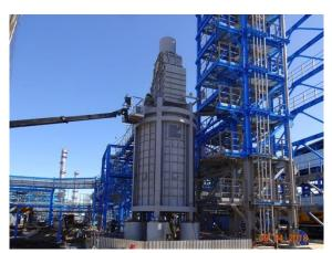
Завершены работы по гидравлическим испытаниям трубопроводов, 60% технологических контуров передано из монтажа в пусконаладку.
