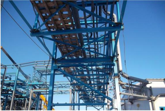
Полным ходом ведутся работы по технологической обвязке блоков гидроочистки, изомеризации и риформинга. Работы по технологической обвязке немодульного оборудования закончены. На данном этапе задействовано 35 сварочных бригад.
