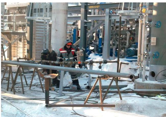
На площадке блока аминовой очистки, предназначенной для утилизации сероводорода, работы по технологической обвязке оборудования близятся к завершению.
