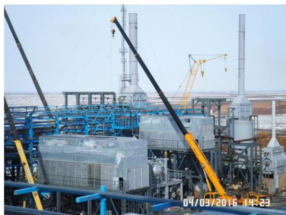
На площадке блока аминовой очистки, предназначенной для утилизации сероводорода, завершены работы по технологической обвязке оборудования, ведутся работы по гидравлическому испытанию трубопроводов.
