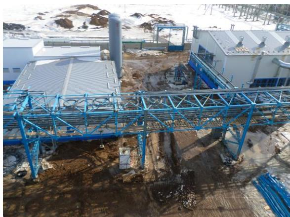
На площадке блока гидроочистки нефти, предназначенного для снижения содержания серы в прямогонном бензине до уровня Евро-5, закончены работы по технологической обвязке, продолжаются работы по гидравлическому испытанию технологических трубопроводов.
