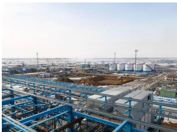
На площадке блока охлаждения технологического теплоносителя-этиленгликоля смонтировано оборудование, ведутся работы по технологической обвязке.
