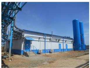
На площадке блока аминовой очистки, предназначенной для утилизации сероводорода, работы по технологической обвязке оборудования завершены, ведутся работы по гидравлическому испытанию трубопроводов.
