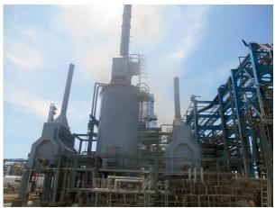
На площадке блока гидроочистки нафты, предназначенного для снижения содержания серы в прямогонном бензине до уровня Евро-5, строительномонтажные работы окончены, завершаются работы по гидравлическому испытанию технологических трубопроводов. Начаты пуско-наладочные работы по
