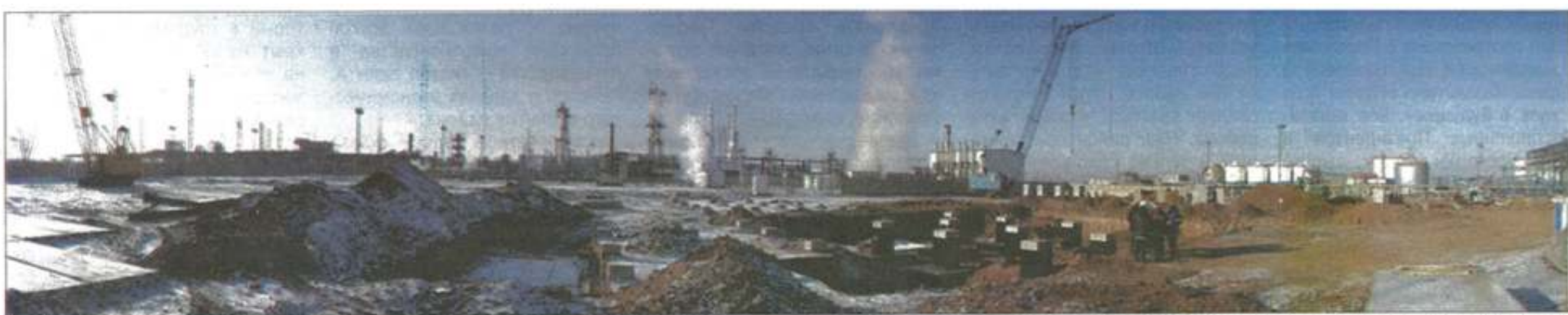
Строительная площадка установки по производству топлив экологического класса K5. Ноябрь 2014 года
